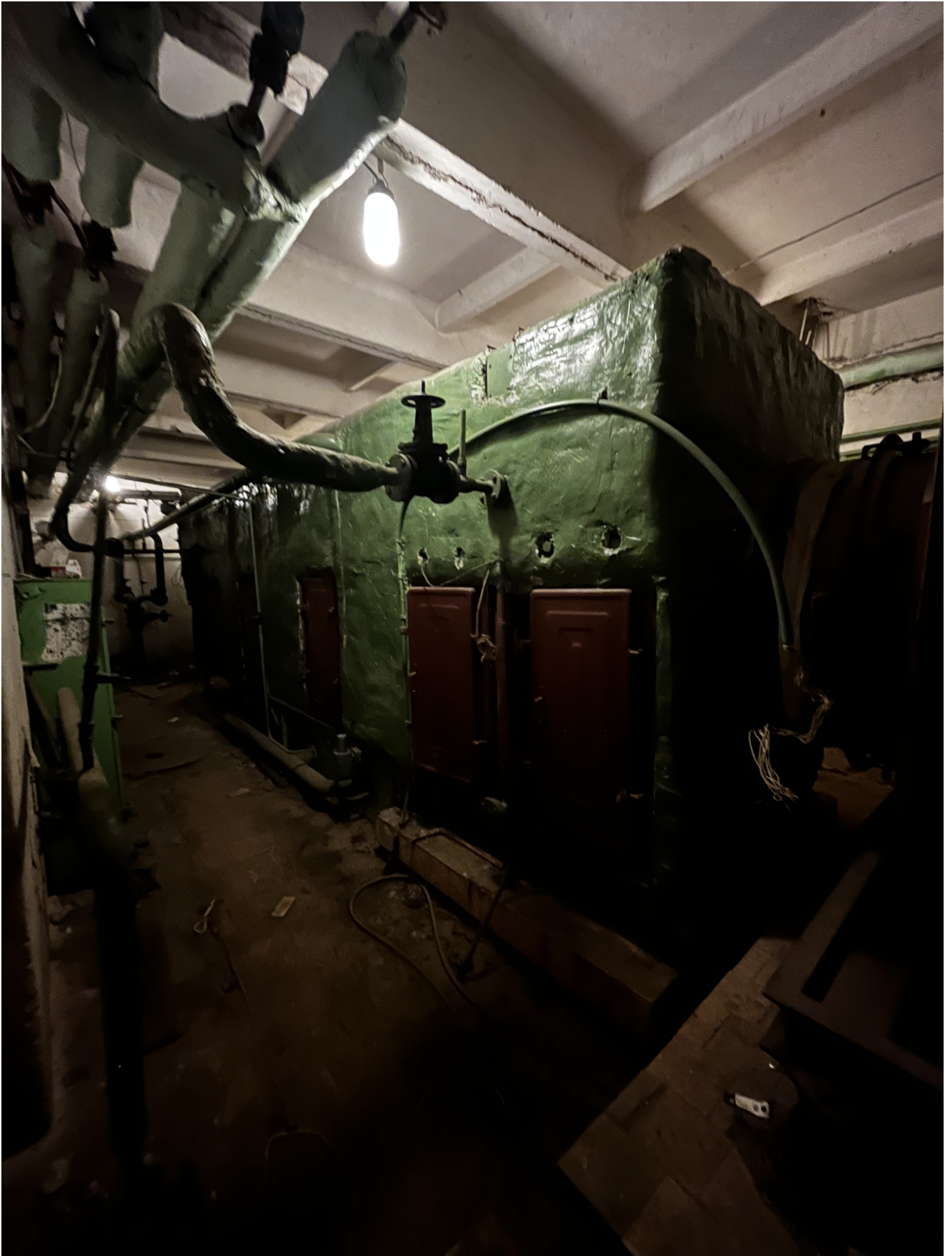
4 pav. Rūsio - priedangos patalpa užpildyta įrengimais (kondicionierius) ir kitais inžineriniais tinklais
