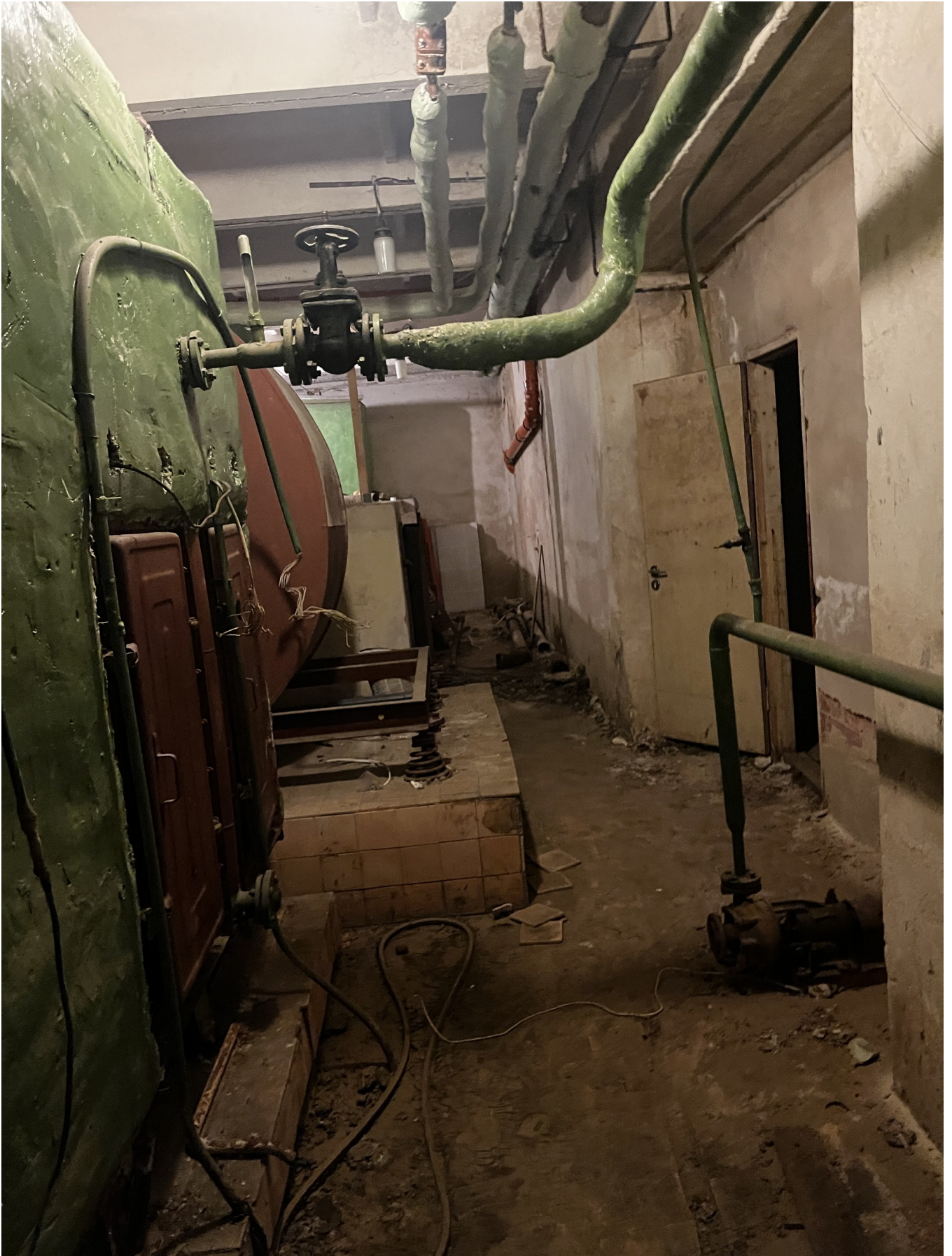
5 pav. Rūsio - priedangos patalpa užpildyta įrengimais (kondicionierius) ir kitais inžineriniais tinklais
